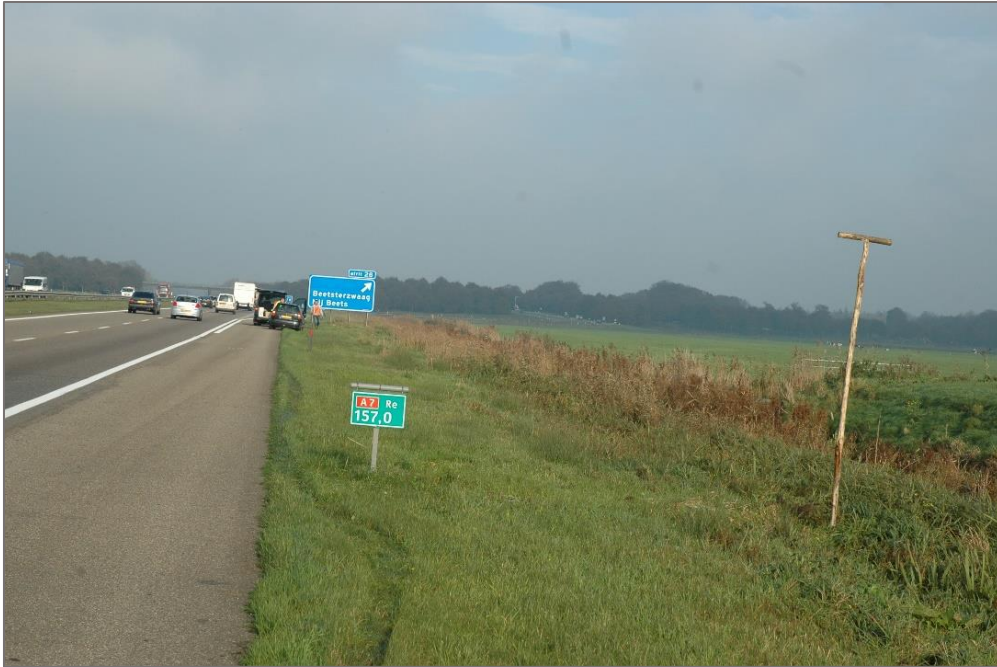
Foto 6: Op 5 november 2014 werden 60 hectometerborden voorzien van een rol en 60 palen met dwarslat op 5 meter vanaf de rijbaan.
