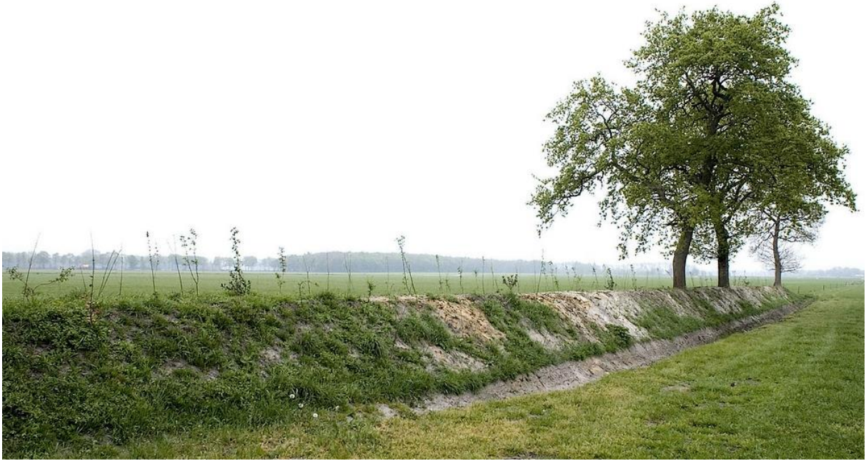
Herstel van een houtwal waar slechts enkele bomen resteerden. De grondwal en de greppels erlangs zijn opnieuw aangelegd, gevolgd door inplant van de kruin van de wal met bosplantsoen (foto Tim Leenders, VNC).
