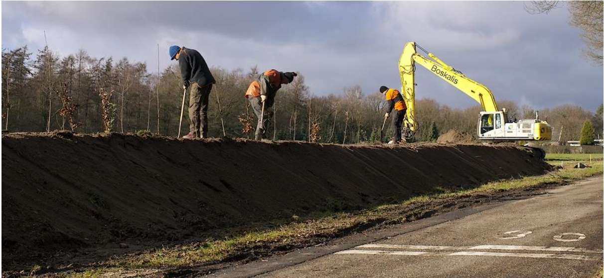
Aanleg houtwal. Alleen de kruin wordt beplant (foto Tim Leenders, VNC).
