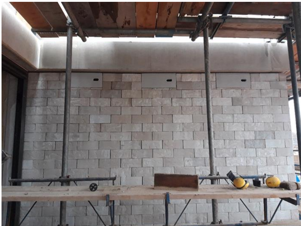
Bewijs: ook met ClickBricks kan je neststenen in metselen. Foto: Jarno van der Dungen
