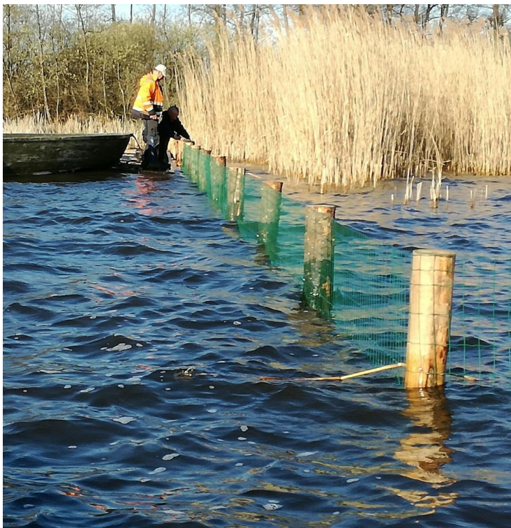
Foto 2. Voorbeeld van pantanet raster. Het raster wordt aan stevige houten palen gemonteerd. Het heeft een ideale maaswijdte en stevigheid.
